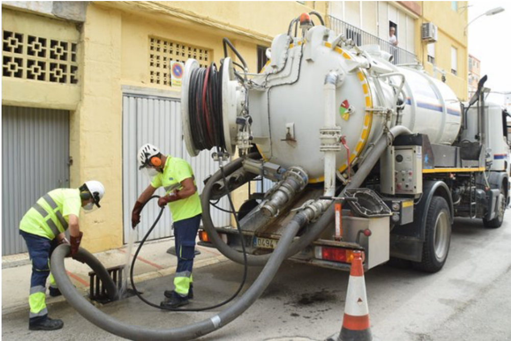
LIMPIEZA PREVENTIVA Y CORRECTIVA RED SANEAMIENTO.
