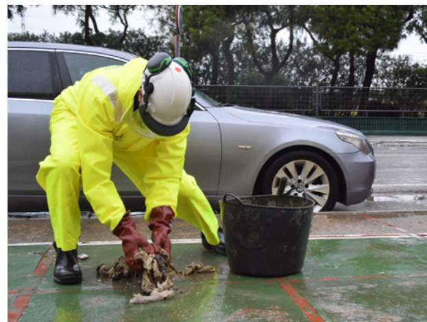
OPERACIONES LIMPIEZA RED DE ALCANTARILLADO.
