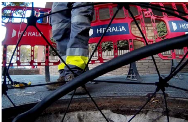
INSPECCIÓN MEDIANTE CÁMARA DE TV
